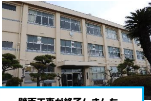
壁面工事が終了しました
