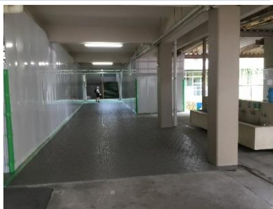
東側1階 給食調理場前 渡り廊下の様子（通行可能）
