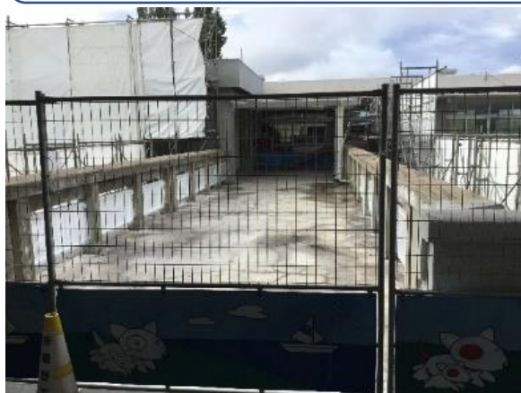
西側3階 渡り廊下の様子
