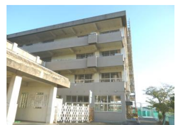
東門付近の資材置場と現場事務所
